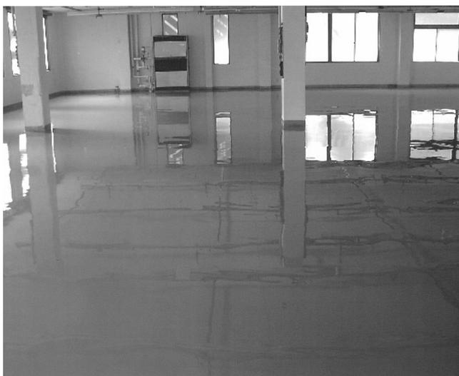
ユカクリート タイルローラー用は、厚膜タイプでありながらローラー塗装を可能にした2液ハイビルド型エポキシ塗床材です。エポキシ樹脂特有の強靱さと高度な塗膜性能を持った、色彩豊かでシームレスな床面が手軽に得られます。
