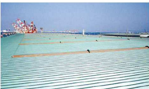
▲ポートアイランド パース屋根 (兵庫県)
