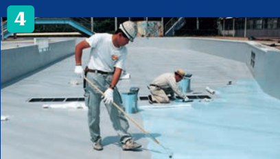
脱泡ローラーを用いガラスクロス内に残っている気泡をつぶしていきます。この作業を行わないとガラスクロスが波打った状態になりますので綺麗に仕上げる事ができません。
