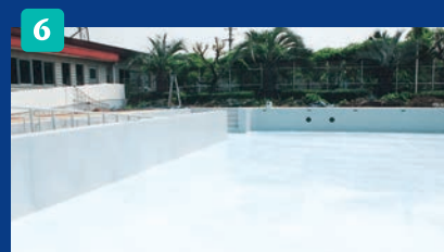
ライニングの作業工程を全て終えた状態です。この表面に中塗り、上塗り用塗料をコーティングすることで美しく強いプールが完成します。
