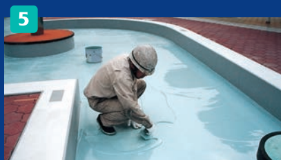
ガラスクロスライニングが乾燥後、ローラー、コテを用い再度ハイボンドを塗り広げます。この作業を行うことで十分な膜厚を持たせることが出来るようになります。
