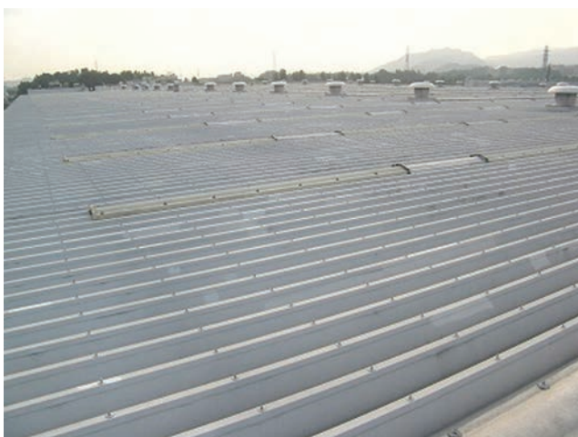
施工前(天然アスファルト系塗料)
