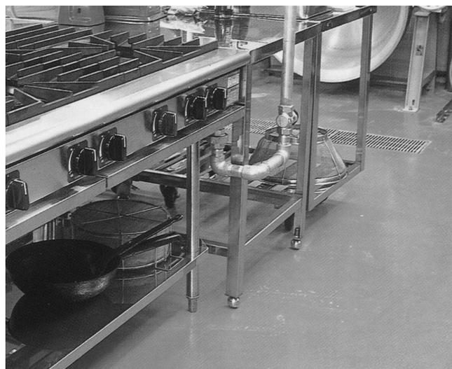
ユカクリート タイル#70はタイルのような硬さとエポキシ樹脂特有の強靱さを生かし、耐摩耗性・耐衝撃性・耐薬品性に重点をおいて設計された製品です。厚膜施工が可能な耐久性塗床材です。
